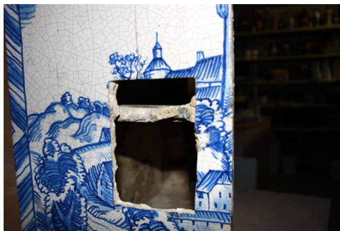
sejmutí nevhodného prvku
